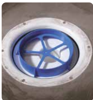
JAFO - Montera JAFO Skärmall med skärmallens taggar i skruvhålen för klämringen.
