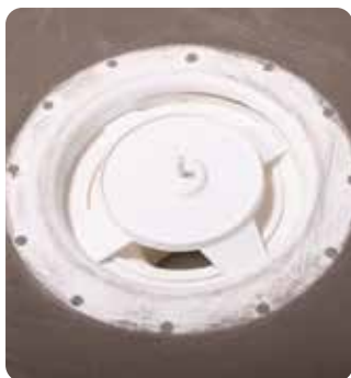
PURUS - Montera foten till PURUS-kniven.
