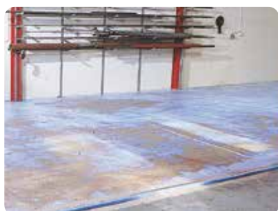
Ytan primas för att få bättre vidhäftning mellan skikten och som skydd mot vattenupptagning.
