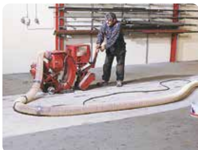
Genom blåstring rengörs golvet från fläckar av olja, kemikalier o.s.v.
