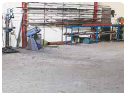
Golvet förbereds för läggning. Ta bort alla lösa inventarier och städa av ytan.
