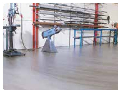
I detta fall lackeras ytan. Golvet togs i bruk redan nästa dag.
