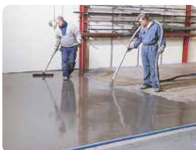
Beläggningen påförs och jämnas av.
