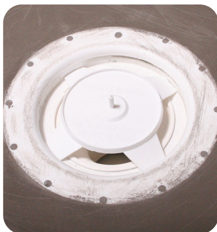
PURUS – Montera foten till PURUS-kniven.
