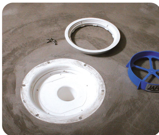
JAFO – Montera JAFO Skärmall med skärmallens taggar i skruvhålen för klämringen.
