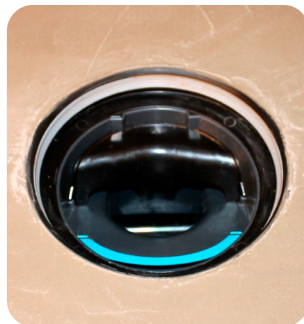
Serres – Kontrollera att brunnens vita/gråa tätning är ren och på plats.
