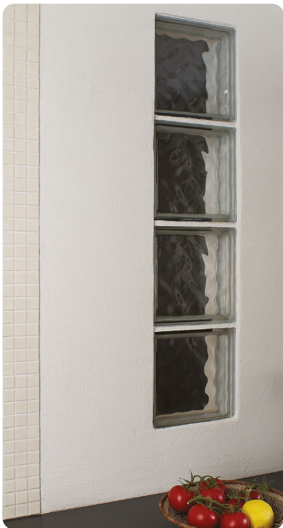
Här har väggen av gammalt murtegel försetts med weber gypsum naturgips.
