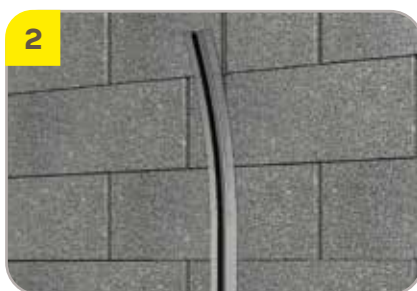
2 Montera webertherm 421 dilfogslist över snittet.
