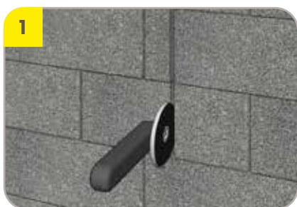
1 Såga ett snitt i väggen med en stenklina för att bestämma var eventuella sprickor ska hamna.
