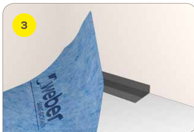
Limma folien mot underlaget med Membran och folielim alternativt med Folie- och skarvlim . Dra bort skyddspapren och pressa fast folien ordentligt, se bild 3.
