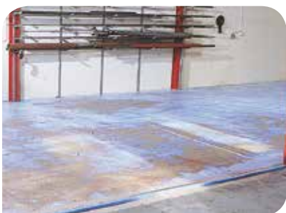
Ytan primas för att få bättre vidhäftning mellan skikten och som skydd mot vattenuptagning.
