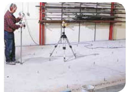
För att ytan ska bli absolut plan mäts nivåskillnaderna upp och markeras.
