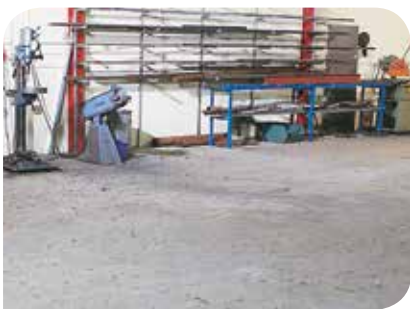
Golvet förbereds för läggning. Ta bort alla lösa inventarier och städa av ytan.
