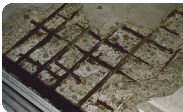
Korroderad armering
