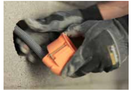
Enkla installationer. VP-rör kan dras vertikalt i stenens hål eller horisontellt i liggfogen.
