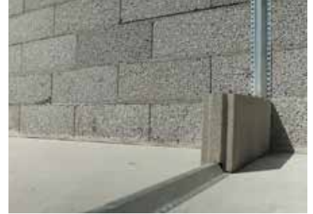
Väggprofilen förenklar arbetet och förankringen till anslutande väggar. Den kan också användas över mindre öppningar.
