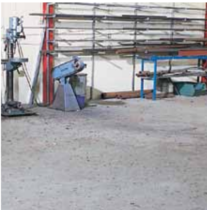
Golvet förbereds för läggning. Ta bort alla lösa inventarier och städa av ytan.
