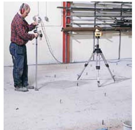
För att ytan ska bli absolut plan mäts nivåskillnaderna upp och markeras.
