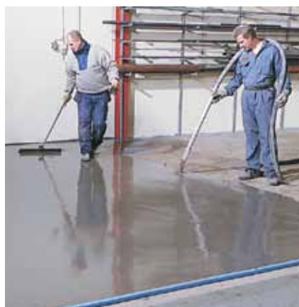
Beläggningen påförs och jämnas av.
