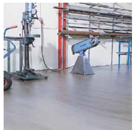
I detta fall lackeras ytan. Golvet togs i bruk redan nästa dag.
