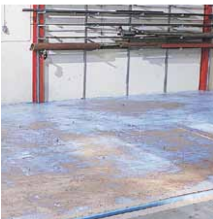
Ytan primas för att få bättre vidhäftning mellan skikten och som skydd mot vattenupptagning.
